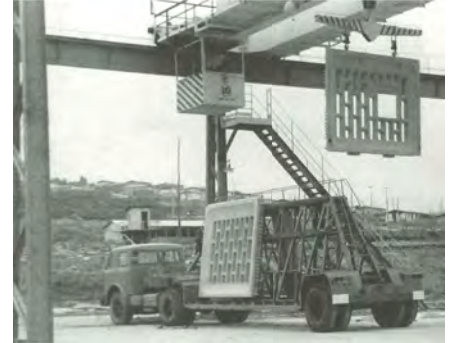
Abb.7 Eine Kranführerin lädt Platten auf einen sowjetischen LKW an der KPD-Anlage, 1973
